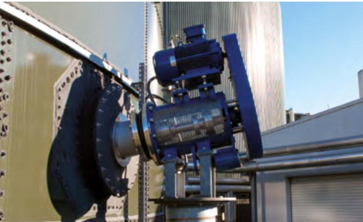
Das Rührwerk im Fermenter wird von einem Motor außerhalb des Tanks angetrieben. Es sorgt für eine gleichmäßige Durchmischung.
