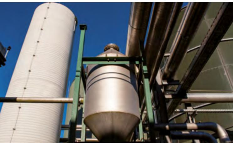
Entschwefelungsanlage (links) und Aktivkohlefilter (Mitte) bereiten das Biogas auf. Blockheizkraftwerke gewinnen daraus Strom und Wärme.
